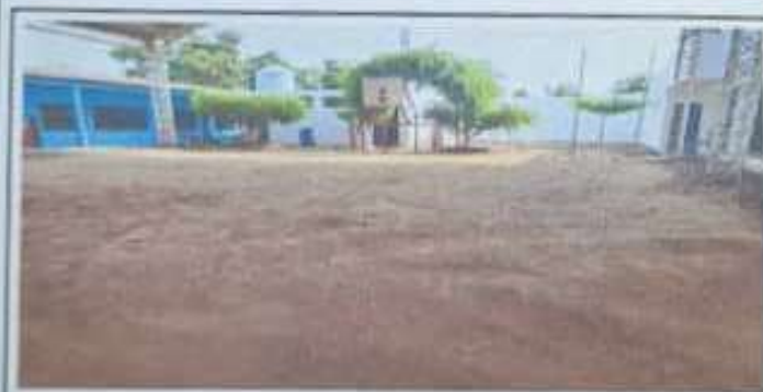
Foto 5: se hizo un relleno de 75 centímetros de alto con fundición debido a las inundaciones durante y después de la lluvia.
