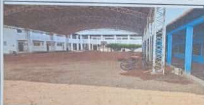
Foto 3: se hizo un relleno de 75 centímetros de alto con fundición debido a las inundaciones durante y después de la lluvia.
