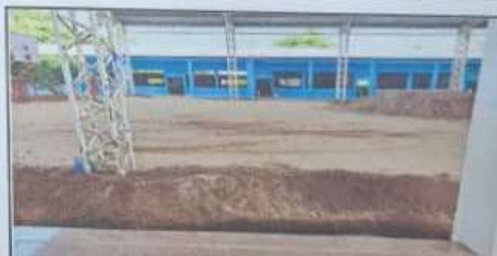
Foto 6: se hizo un relleno de 75 centímetros de alto con fundición debido a las inundaciones durante y después de la lluvia.
