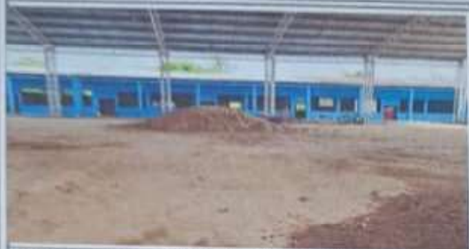
Foto 1: se hizo un relleno de 75 centímetros de alto con fundición debido a las inundaciones durante y después de la lluvia.
