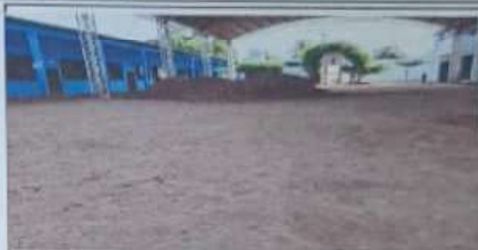
Foto 2: se hizo un relleno de 75 centímetros de alto con fundición debido a las inundaciones durante y después de la lluvia.
