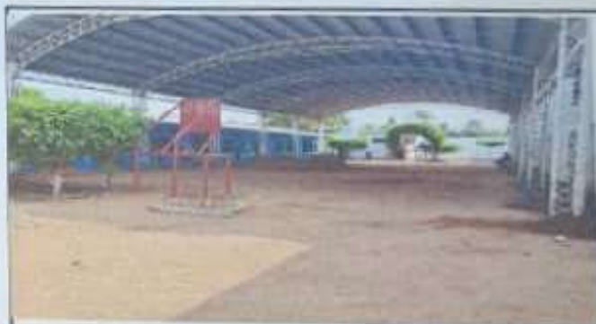
Foto 4: se hizo un relleno de 75 centímetros de alto con fundición debido a las inundaciones durante y después de la lluvia.
